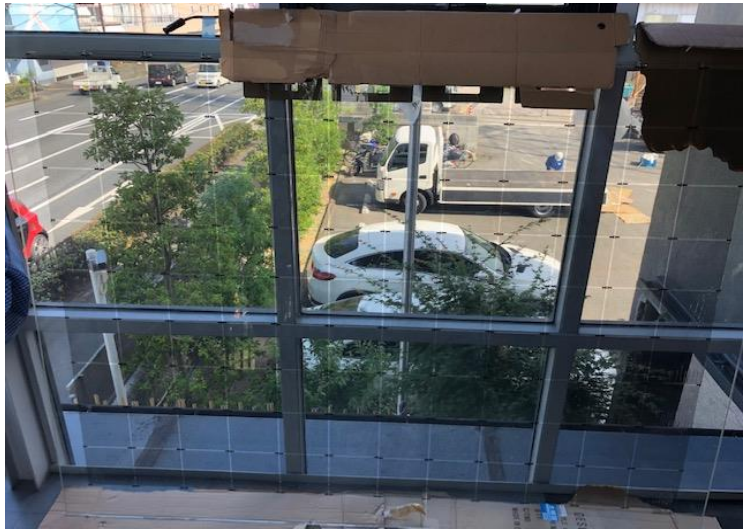
スフェラー®内蔵シースルー 太陽電池ガラスモジュール
