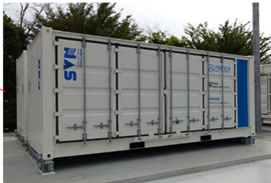
NAS電池 400kW/2,400kWh
