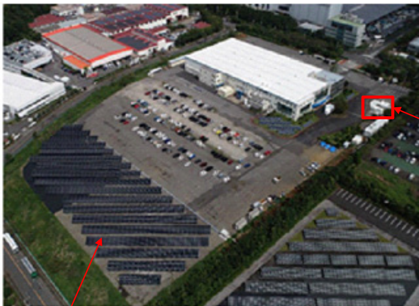
太陽光発電システム 670kW
